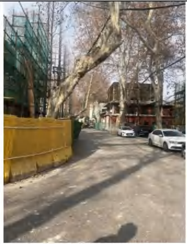
DR 检测室东（厂内道路）
