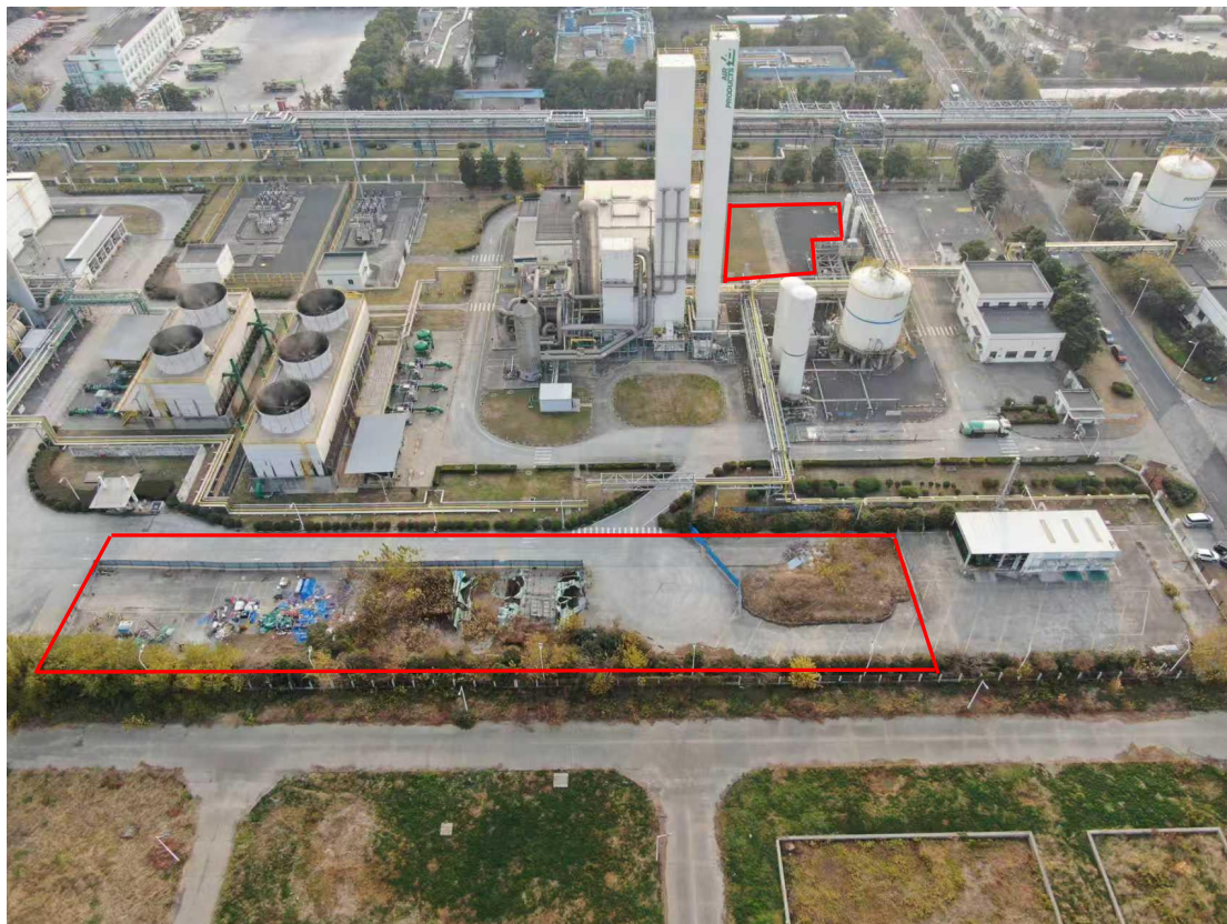
图 2.1-1 项目区现状照片（2026 年 2 月）
