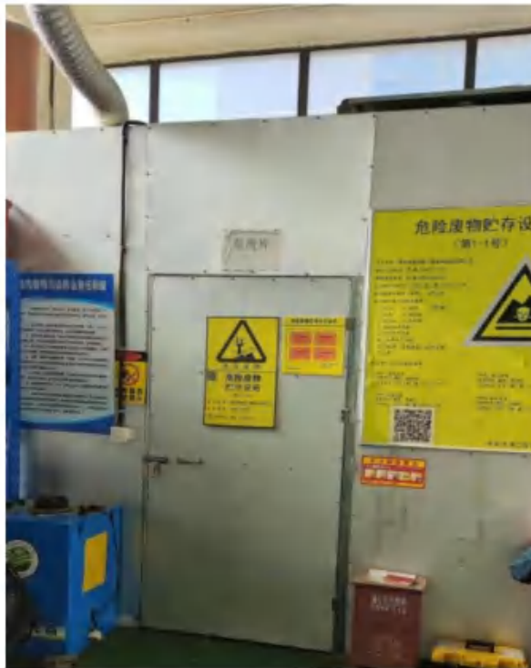
危废库门口公示牌
