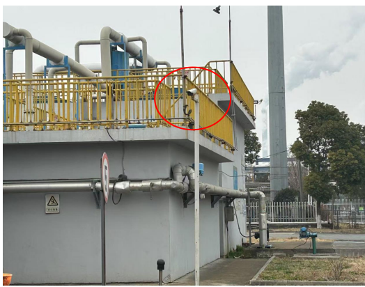
危废暂存间外部视频监控
